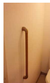
手すりの設置
